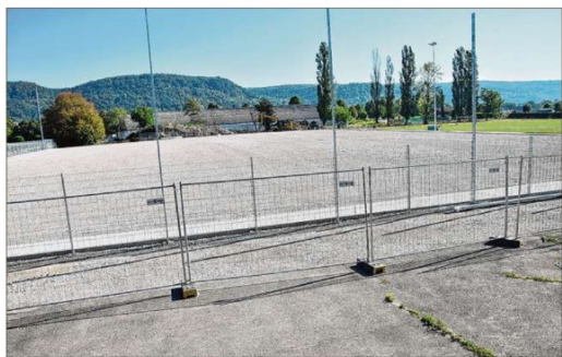
Die Tiefbauarbeiten für den neuen Kunstrasenplatz sind beinahe abgeschlossen. Foto: Heinz Vollmar
